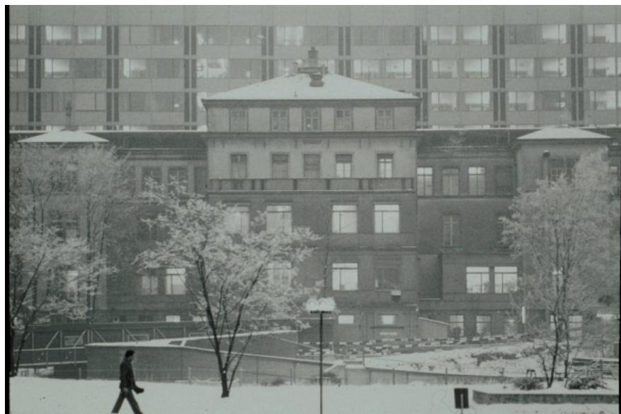
Abb. 12: Blick vom Spitalgarten auf den Merian-Bau (im Hintergrund das im Bau befindliche Klinikum II), die beleuchteten Fenster markieren die Räumlichkeiten der damaligen nuklearmedizinischen Abteilung.
